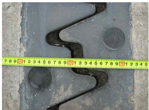
신축이음 이동량 측정
